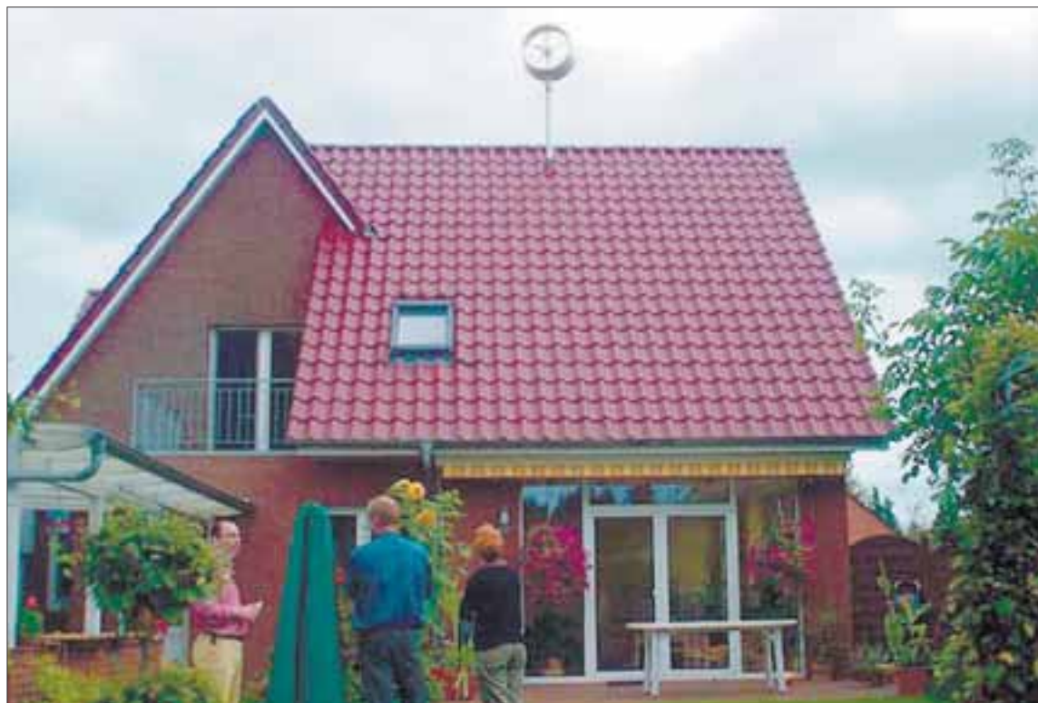
El enflo se coloca en el tejado de las viviendas, de la misma forma que las antenas parabólicas.
